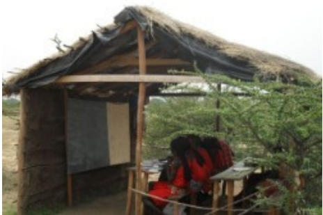
Das extra für den Unterricht im Oloshaiki Village errichtete Schul-Shelter
